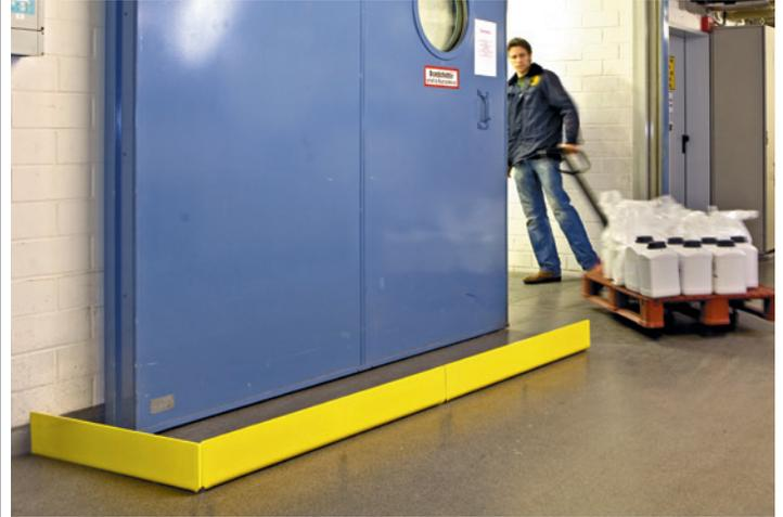
Häufig werden Lager-, Brandschutztüren und -tore beschädigt. Ursache: In der Sperrfläche im Rückfahrraum wurden Paletten/Gitterboxen abgestellt. Auch durch Staplerfahrer, die in diesen Bereich einfahren, während sich das Tor öffnet, können Schäden verursacht werden.
