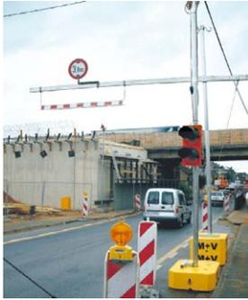
Die mobile Höhenwarnanlage HWA dient zur Vermeidung von Fahrzeug- und Brückenschäden nicht nur während Baumaßnahmen oder in geänderten Verkehrsführungen. Typische Einsatzbereiche sind zum Beispiel: Brückenbauwerke, Bahnunterführungen, Tunneldurchfahrten, Hallen-, Tiefgaragen- oder Parkhauseinfahrten u. v. m.
